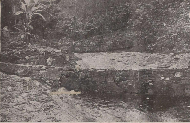
பழனிமலையில் காப்பித் தோட்டங் களிடையே ஓடும் நீரோடை களின் குறுக்கே கட்டப் பட்டுள்ள தடுப்பு அணைகள் (Check Dams).
