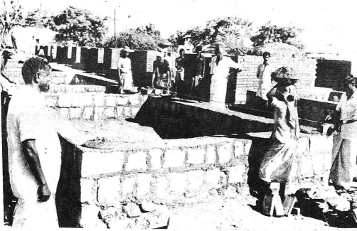
தனக்கன்குளம் ஆதிராவிடர் வீடு கட்டும் பணி
