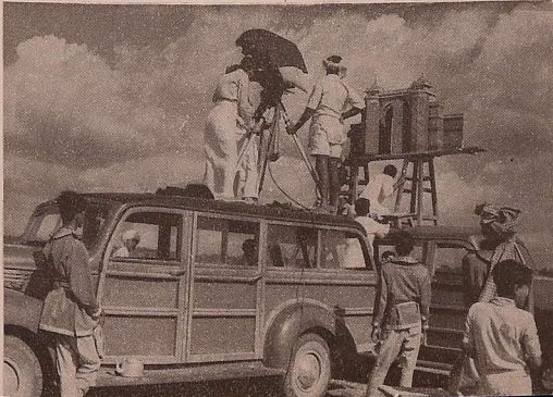
தண்டவாளங்களின்மீது நகரக்கூடிய வண்டியில் காரிராலை வைத்து சினிமாப் படம் எடுக்கிறார்கள். மேலே உள்ள குமாயின் முனையில் குரல் ஒலியைப் பதிவுசெய்யும் கருவி உள்ளது. ஒளிப்பதிவும் ஒலிப்பதிவும் தனித்தனியே செய்யப்பட்டுப் பின்னர் தொகுக்கப்படுகின்றன.
