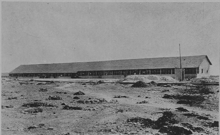
Main building T shaped (300 ft. & 150 ft.) long & 36 ft. broad on 20 acre block 20 ஏக்கர் பூமியில் 'T' வடிவிலானதான கட்டடம் கம்பீரத்துடன் விளங்குகின்றது
