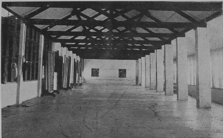
Interior view of the main building 450 ft. long & 36 ft. broad on a 20 acre block பிரதான கட்டடத்தின் உட் தோற்றம்
