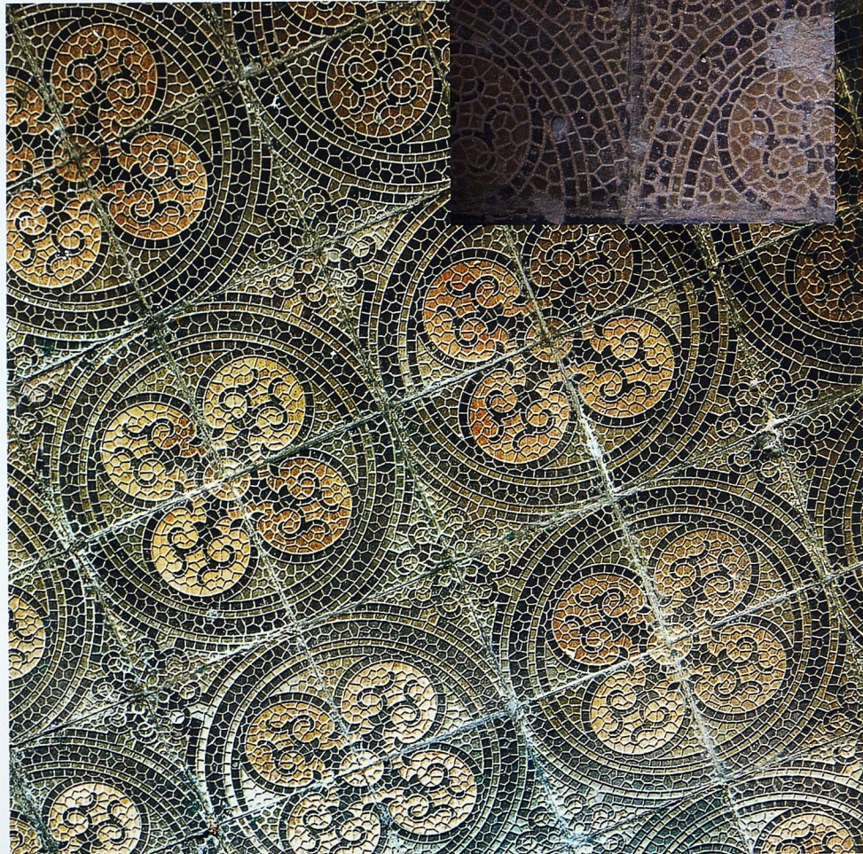
துணை வேந்தரின் அறையில் மின்டன் ஓடுகள் வேயப்பட்ட தரை 130 ஆண்டுகளுக்கு பின்னும் நல்ல நிலையிலேயே இருந்தது. அந்தத் தரை சுத்தப்படுத்தப்பட்ட பின்பு எடுக்கப்பட்ட படம். (உள்படம்) சுத்தப்படுத்தப்படுவதற்கு முன்பு ஓடுகள் அமைப்பின் படம்.
